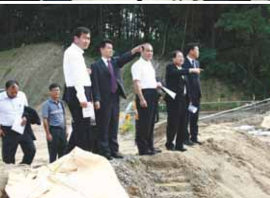
▲ 신둔면 체육시설 조성공사 현장 점검
