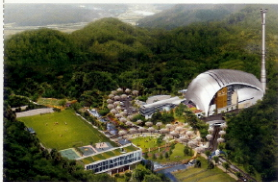
동부권 광역자원 회수시설
