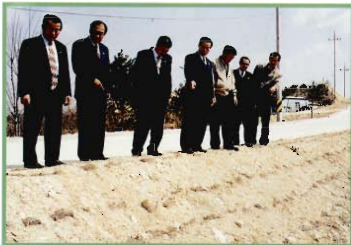
아미~가산철동마을 간 도로확·포장 공사 현장을 방문, 점검하는 의원들
