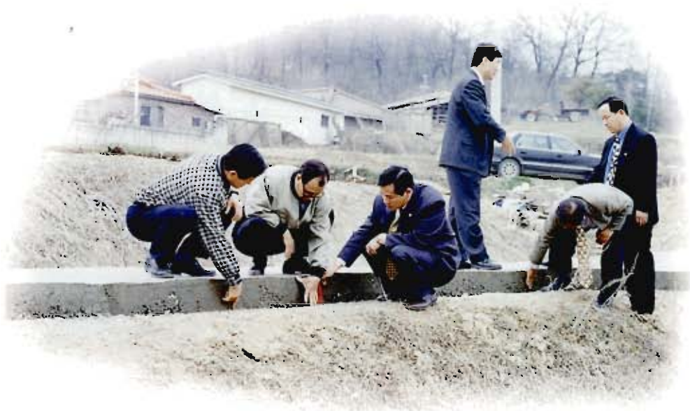
호법면 주미, 주박, 동산, 단천지역 기계화 경작로 포장공사 현장을 방문, 시공상황을 점검하는 의원들
