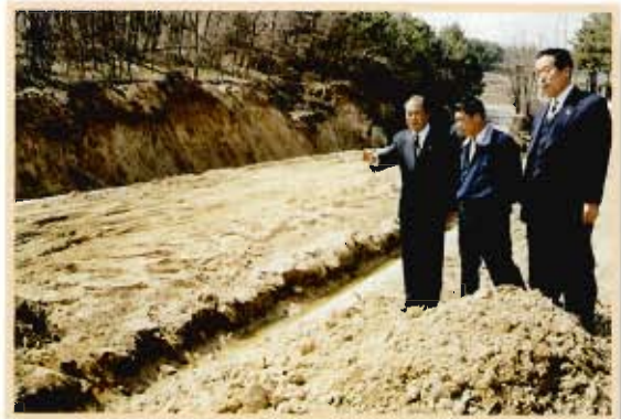
설성면 제요리 제요천 개수공사 현장을 점검하고 있는 의원들
