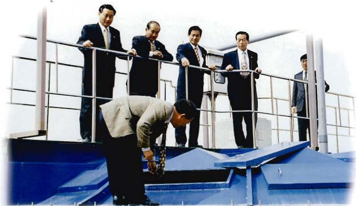
갈산동 하수종말처리장 대형 정화조 공사 현장을 점검하는 의원들
