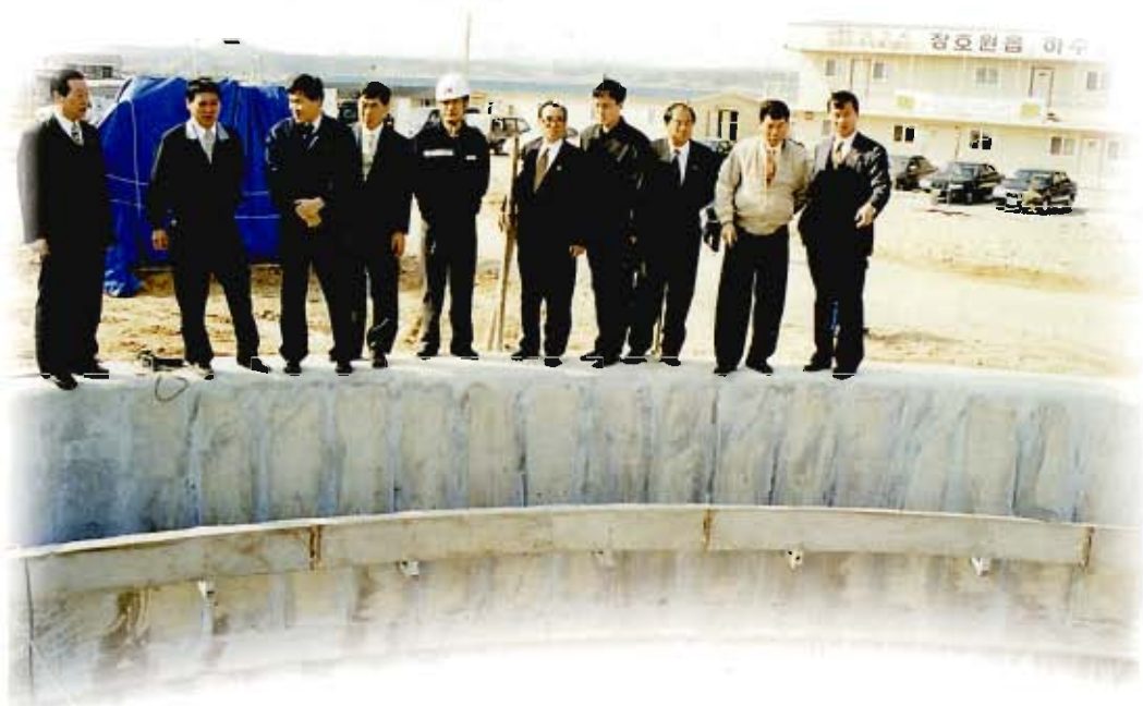
장호원읍 하수처리 공사현장을 방문, 공사 관계자로 부터 현황을 청취중인 의원들
