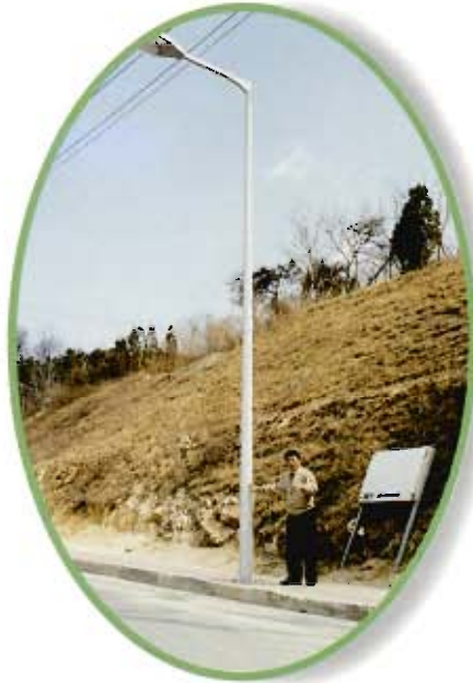
민원사업인 사동4리 진입로 가로등 설치 및 보도설치공사 현장 방문
