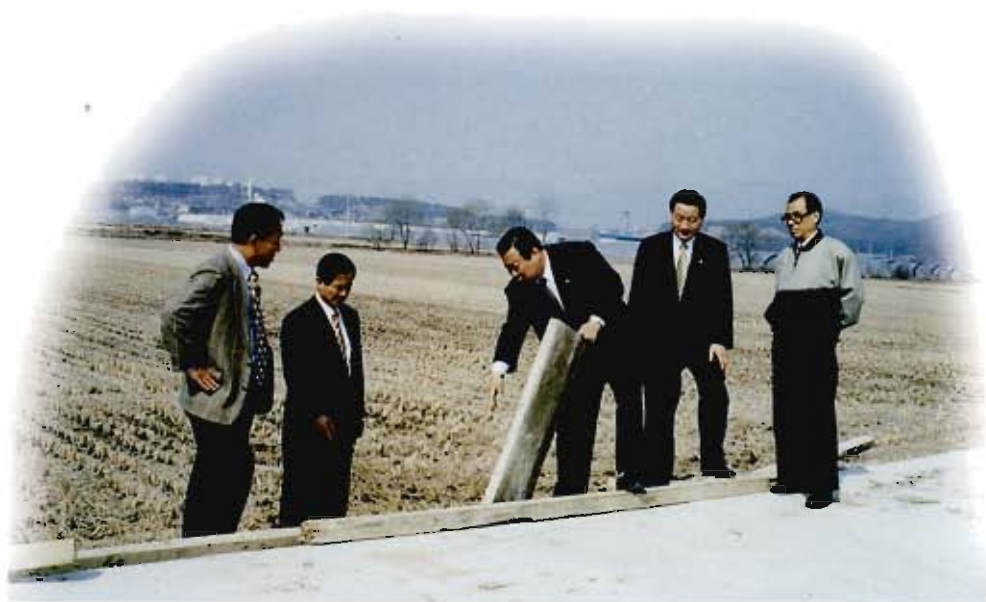
모전리 농로개설 현장을 방문, 시공현장을 둘러보고 점검하는 의원들
