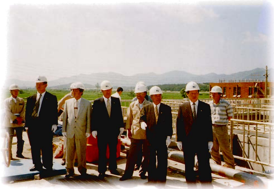
이천하수처리시설공사 현장 확인('97. 6. 28)
