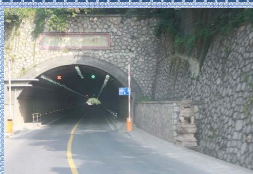
터널 내 자전거 도로
