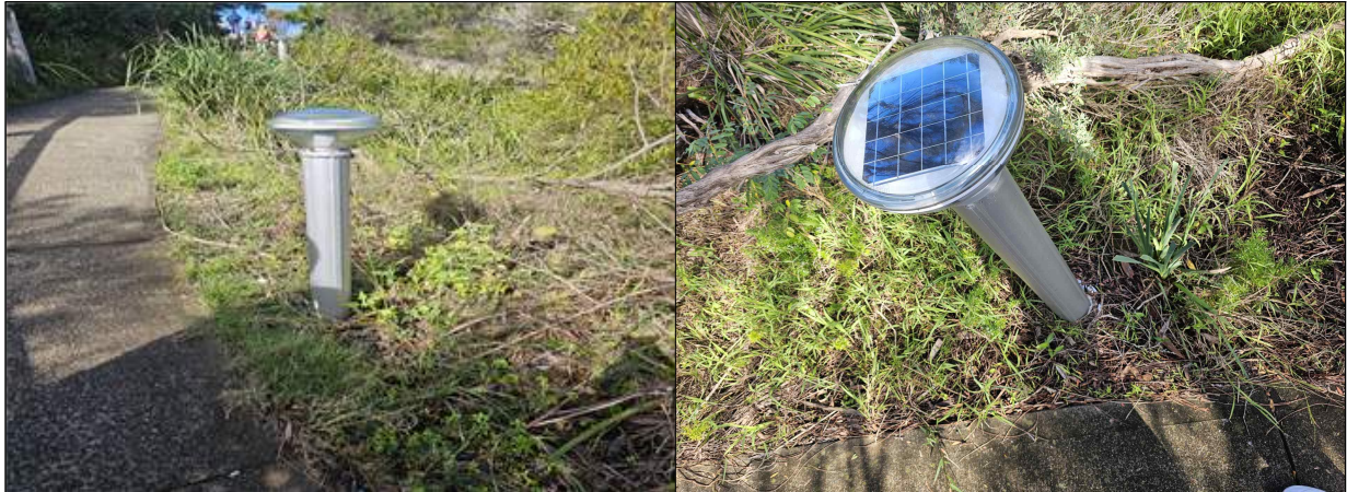
호주 태양광 가로등
