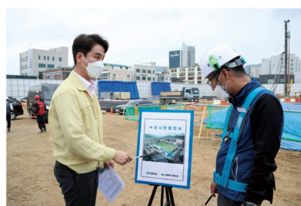
공설운동장 주차장 조성현장 확인
