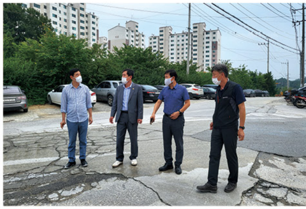
도로 파손으로 인한 민원 현장 확인(대월면)
